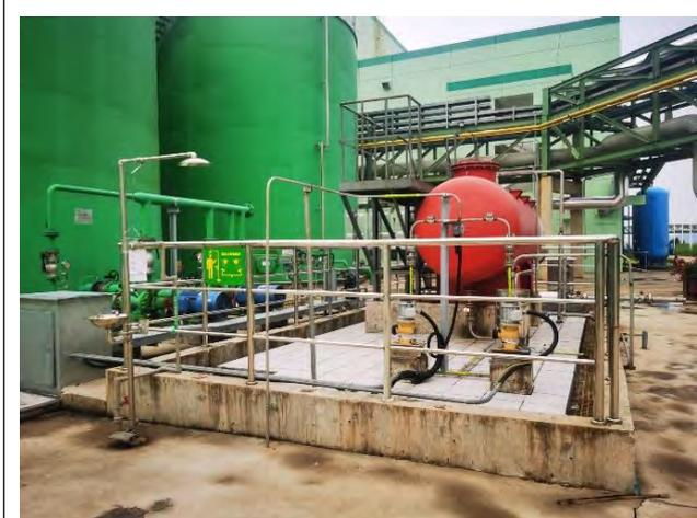
燃气电厂 20%氨水罐（4T）围堰和洗眼器
