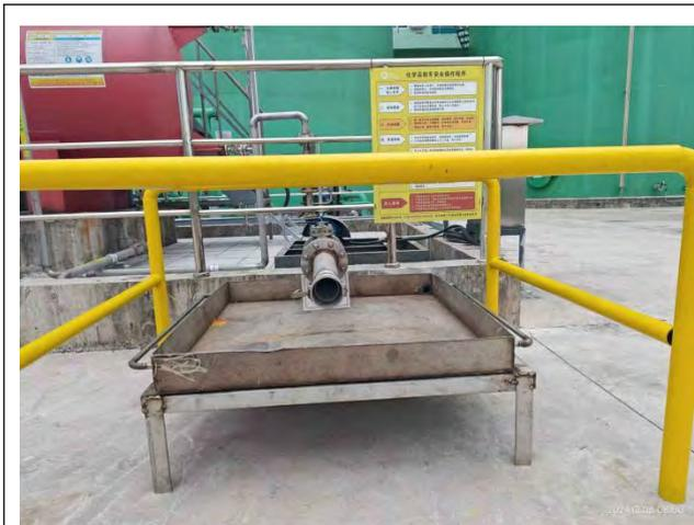
燃气电厂 20%氨水罐（4T）卸料口防泄漏托盘
