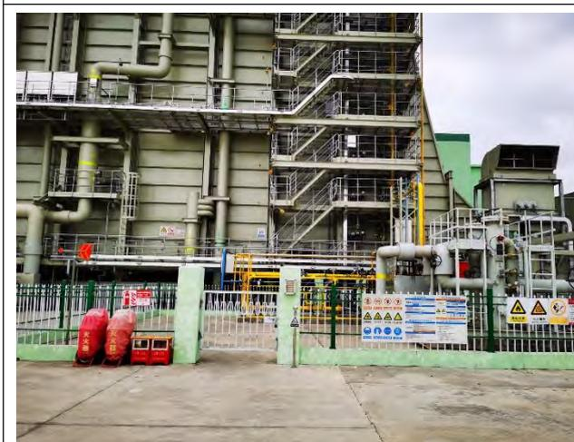
燃气轮机区域消防设施和风向标、除静电装置
