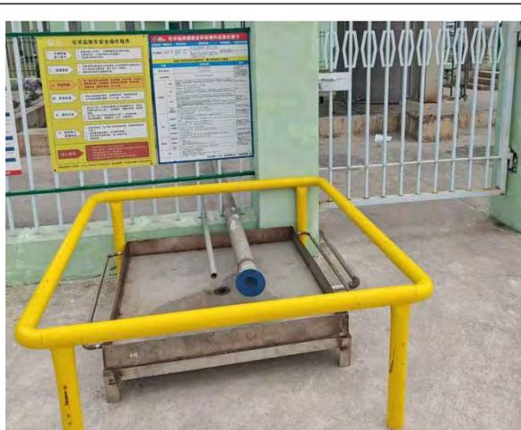
燃气电厂 20%氨水罐（10T）卸料口防泄漏托盘
