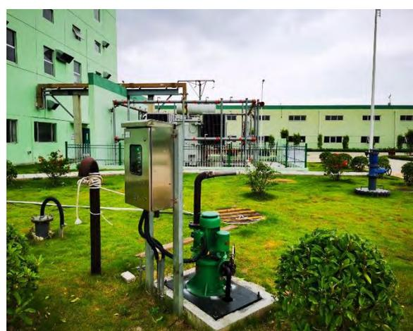
汽机主变地下式事故油池和抽送转移泵
