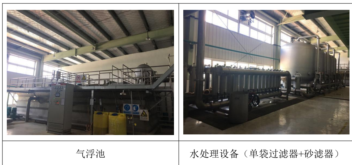
图 4.1-1 水刺车间废水处理设施图片
