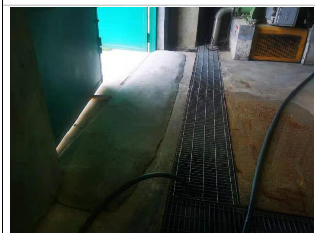
车间门口防泄漏缓坡和地沟
