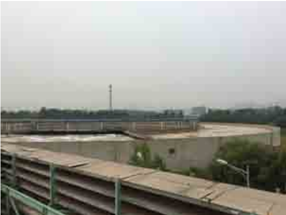
照片 7 厂区污水处理场
