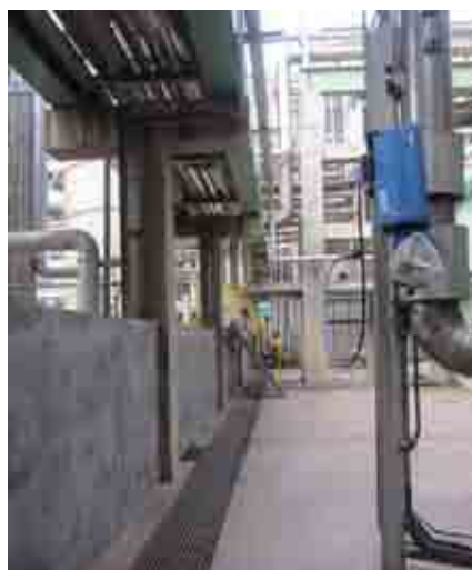
照片 10 化工原料储备区中间分隔围堰及地沟
