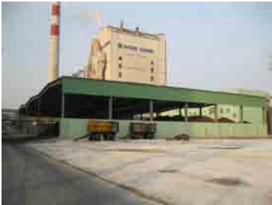
照片 9 一般固废暂存场
