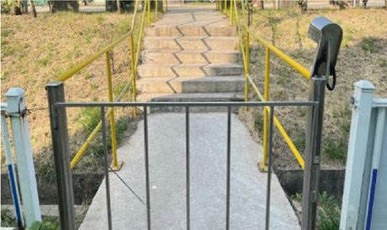
危化品车间员工进出通道加装磁吸栅栏门和身份识别验证系统
