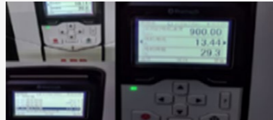
冷却塔风机及污泥回流泵变频改造
