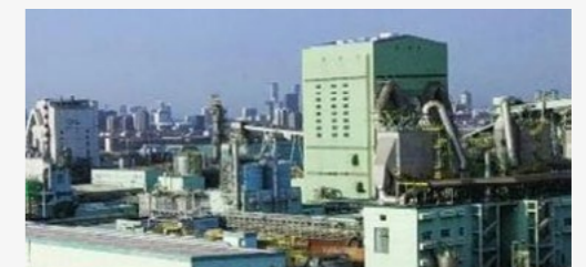
碱回收炉脱硝工艺升级改造项目
