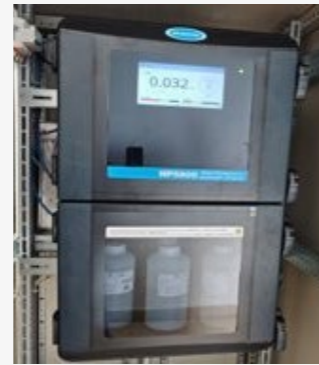
废水排放口在线监控升级改造
