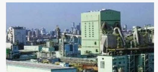
碱回收炉脱硝工艺升级改造项目
