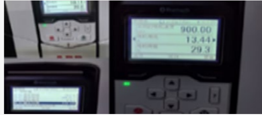
冷却塔风机及污泥回流泵变频改造
